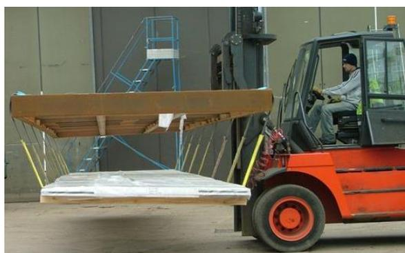
In allen Fällen der **Handhabung** und Lagerung muss vermieden werden, dass die Paneele beim Manövrieren durch Reibung zerkratzt werden.
