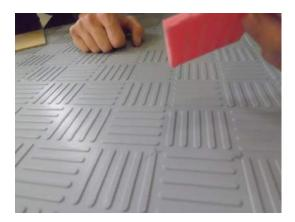
12. Bei Bedarf können Sie den Überschuss mit einem Spachtel und etwas Aceton abkratzen
