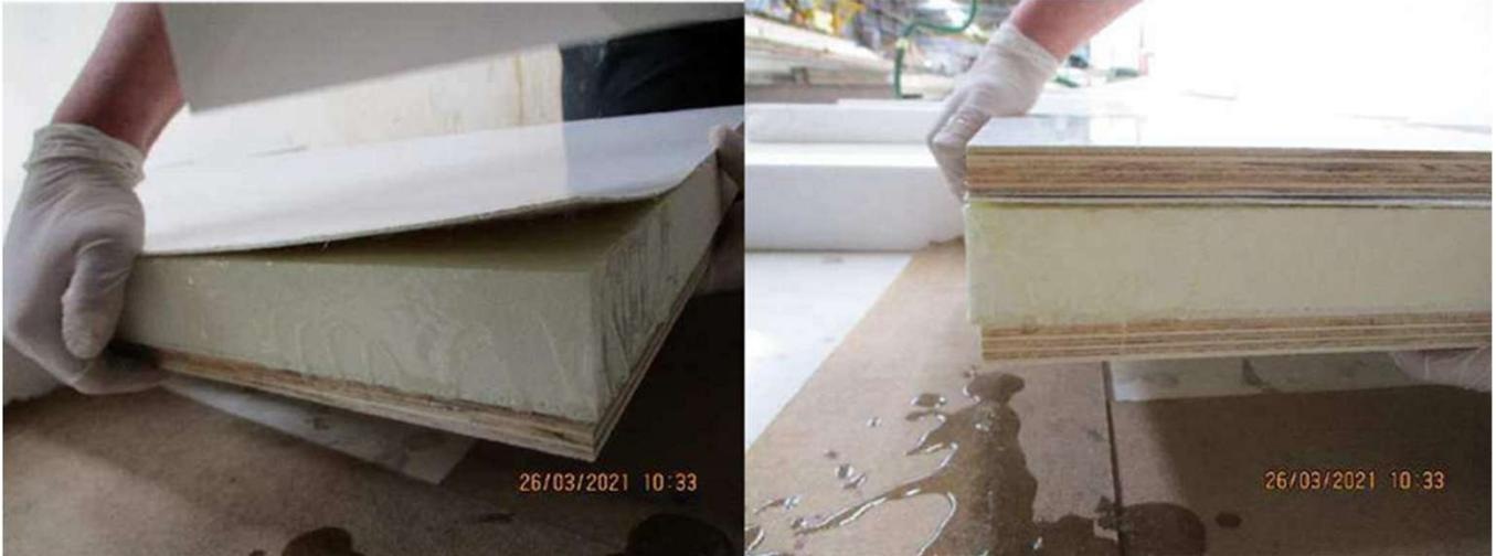
6. Coloque la primera abrazadera y no retire el exceso de resina como se muestra en la foto de abajo.
