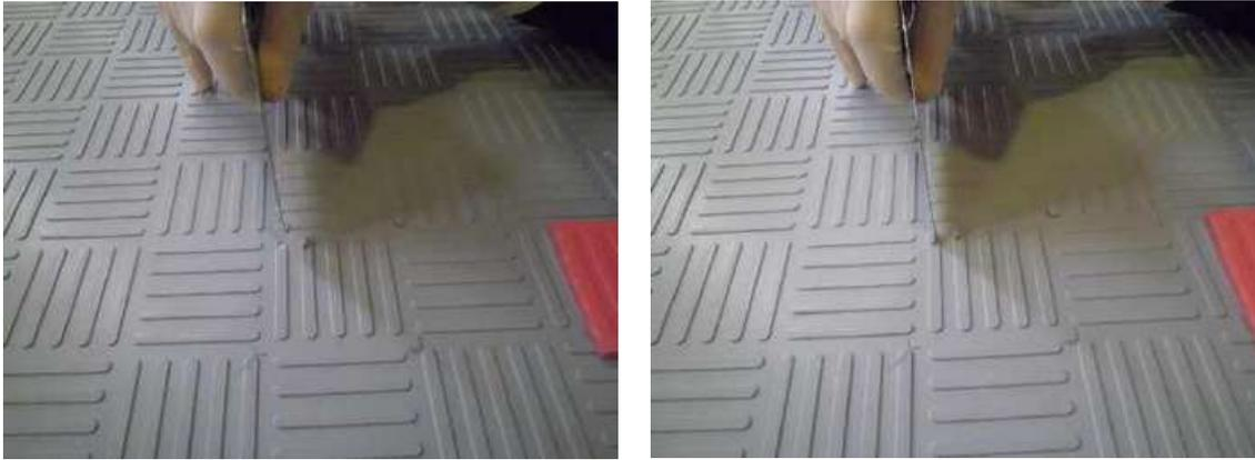
9. Coloca el molde utilizando las marcas que has hecho
