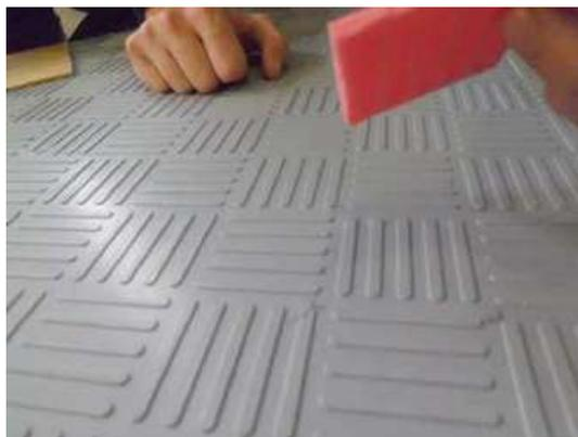
13. Bei Bedarf können Sie den Überschuss mit einem Spachtel und etwas Aceton abkratzen
